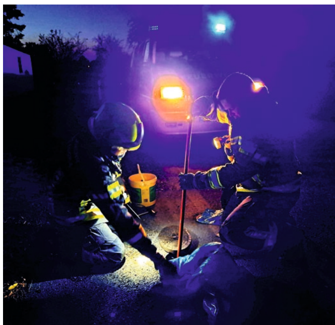
Kontrolle der Unterflurhydranten zur Löschwasserversorgung auf Funktion
