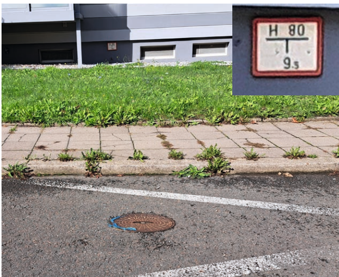
Beispiel für einen Unterflurhydranten mit zugehörigem Hinweisschild an der Hauswand
